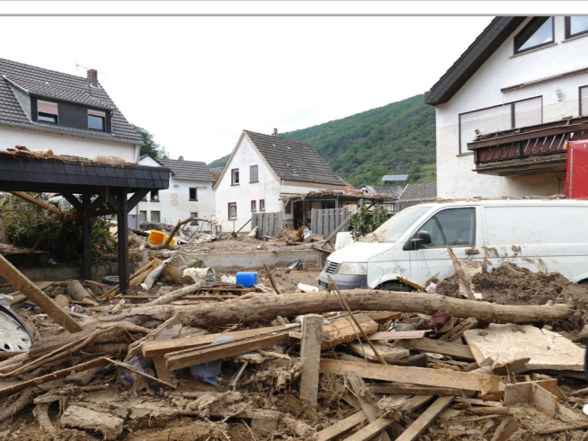
Zerstörung in Altenburg (Sichtbare Hochwasserlinie)
