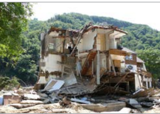
Zerstörtes Haus nahe Marienthal
