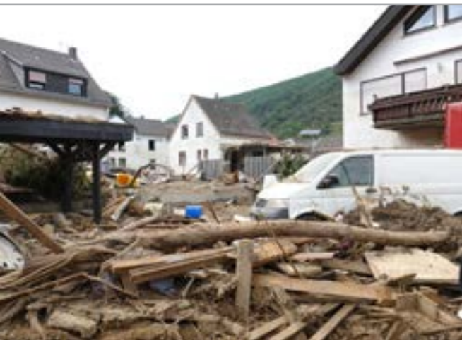
Zerstörung in Altenburg (Sichtbare Hochwasserlinie)
