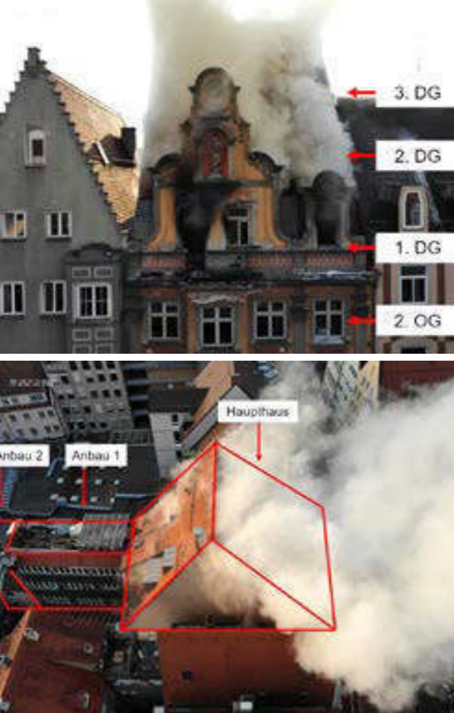
Bild o.: Frontalansicht des Dachstuhls in Phase 1. 2. OG und 1. DG sind gut erkennbar. 2. und 3. DG werden durch die Rauchsäule verdeckt. Ein Übergreif des Feuers auf den linken Nachbardachstuhl war zu befürchten. Bild u.: Draufsicht der Einsatzstelle in Phase 1 aus südlicher Richtung. Der Anbau ist gut erkennbar, genauso wie die ungünstige Anleiterbarkeit an den Dachstuhl von der Rückseite aus.
