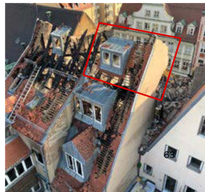
Das einsturzfähige Südgiebelstück mit dem Rest des Dachaufbaus wurde kontrolliert abgerissen, so dass es in das Brandobjekt stürzte, ohne weiteren Schaden zu verursachen.
