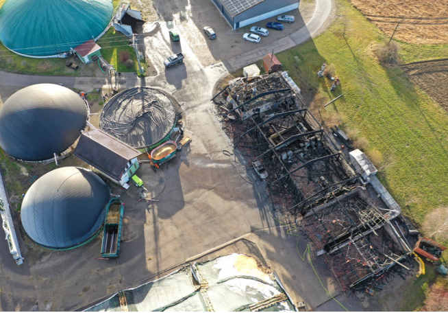
Luftaufnahme der abgebrannten Maschinenhalle und des zerstörten Fermenters
