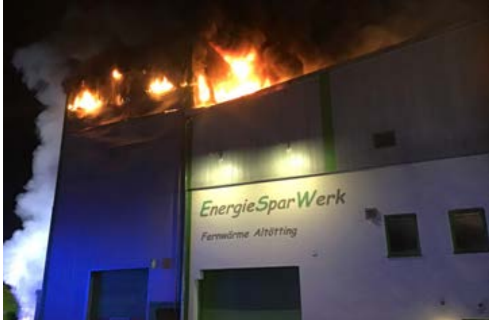
Westseite, Flammendurchschlag auf die Südseite 22:28 Uhr
