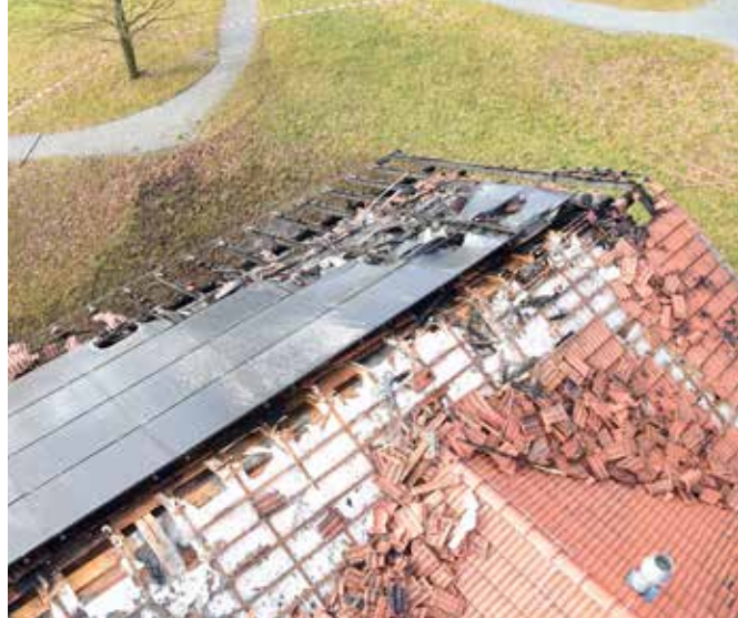
Bild aus DLK am Tag nach dem Brand. Deutlich sichtbar sind die erheblichen Schäden am westlichen Gebäudeeck
