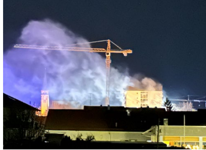
Die Sicht aus Richtung Norden auf das brennende Gebäude
